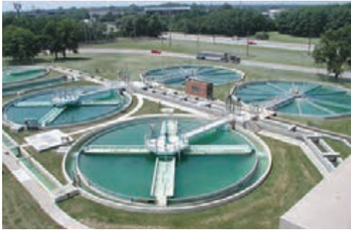
تصفیه آب در تصفیه خانه
