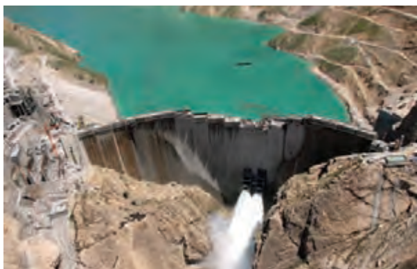
شکل ۷- سد کارون (۴) - خوزستان
