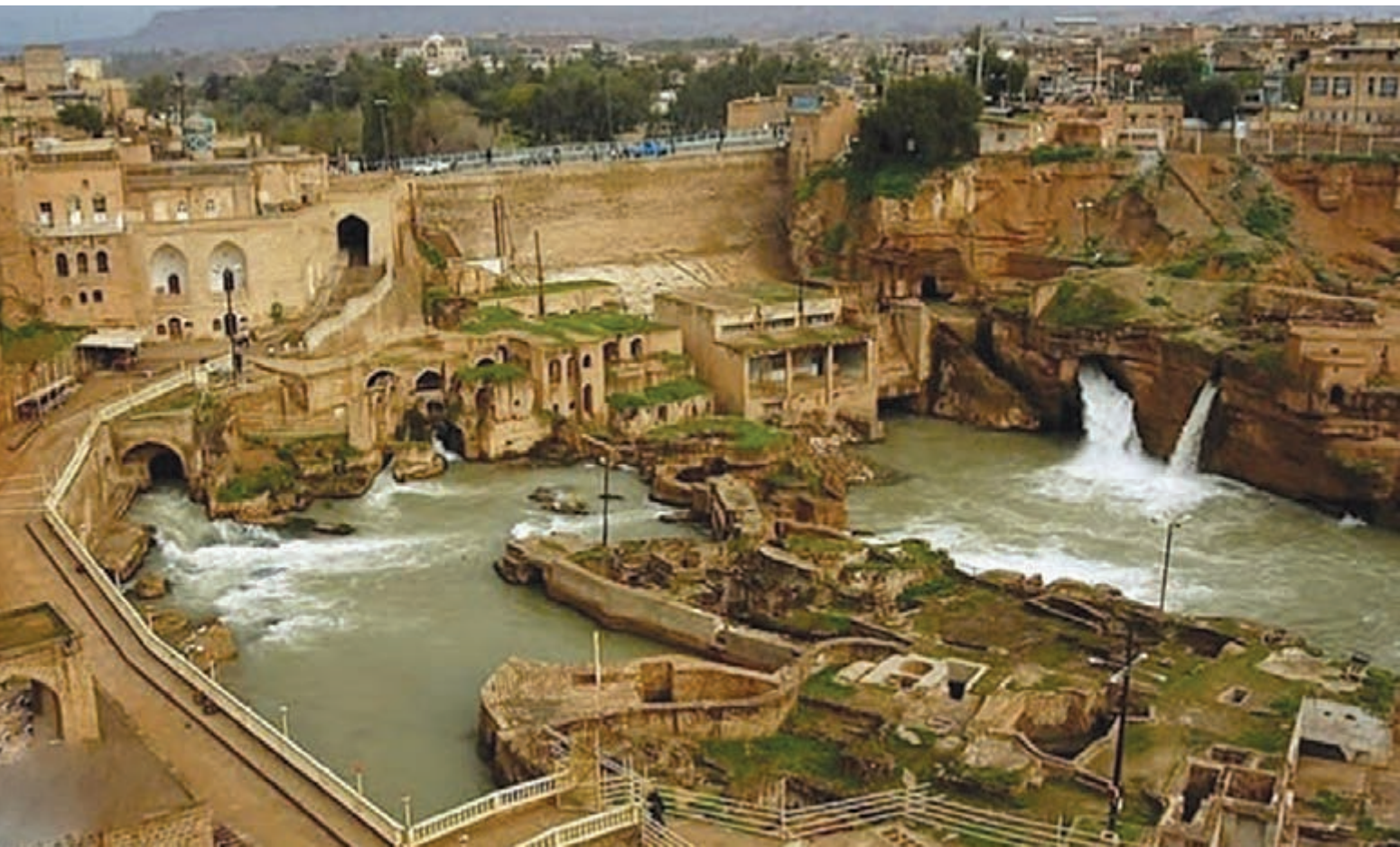
شکل ۵- سازه‌های آبی - تاریخی، شوشتر، خوزستان
