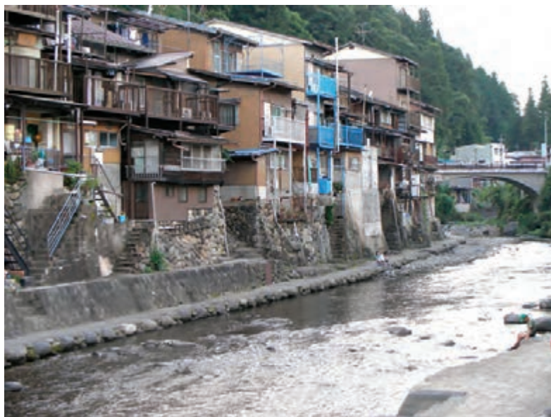
شکل ۱۶- عدم رعایت حریم آب
