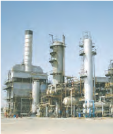
ب) نمای بیرونی برج تقطیر در پالایشگاه
