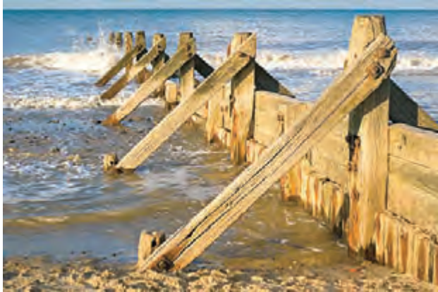
نصب حفاظ عمودی
