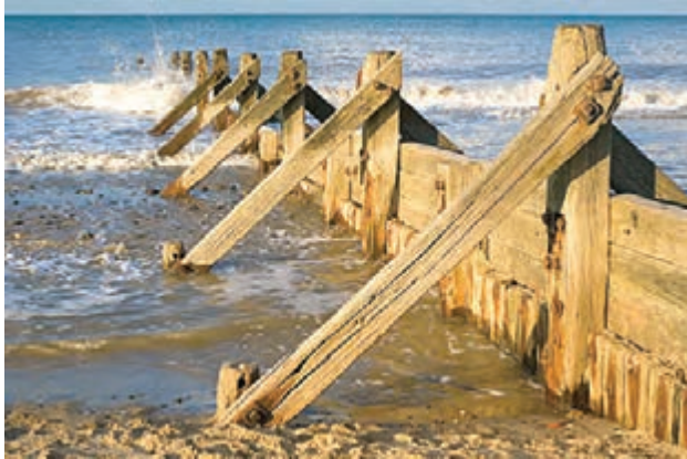
نصب حفاظ عمودی
