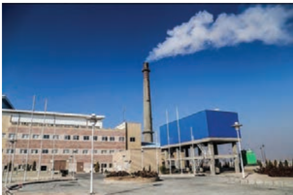
اولین نیروگاه زباله‌سوز تولیدکننده برق در کشور ما، نیروگاه آرادکوه کهریزک در تهران است که در سال ۱۳۹۳ به بهره‌برداری رسید و ظرفیت تولید کنونی آن ۳ تا ۵ مگاوات برق ساعت از ۲۰۰ تن زباله است.
