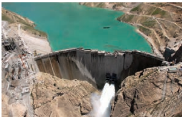
شکل ۷- سد کارون (۴) - خوزستان
