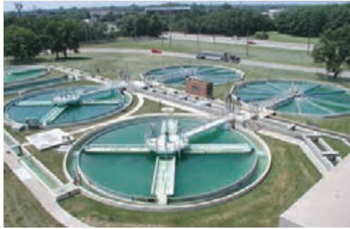
تصفیه آب در تصفیه خانه
