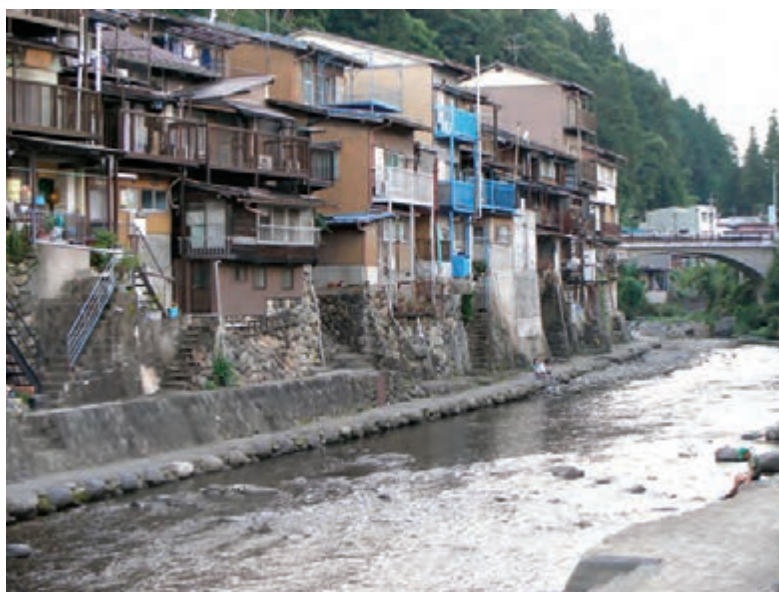
شکل ۱۶- عدم رعایت حریم آب
