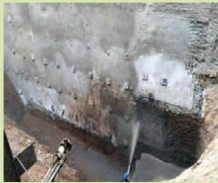
پایدارسازی شیب به روش میخ کوبی
