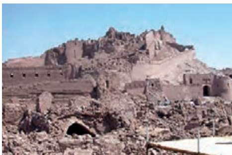
ارگ بزم، بزرگ‌ترین سازه خشتی جهان در زلزله بزم دچار تخریب زیاد شد.
