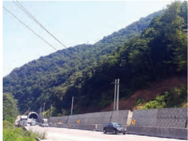
نصب حفاظ بتونی - جاده قائم‌شهر
